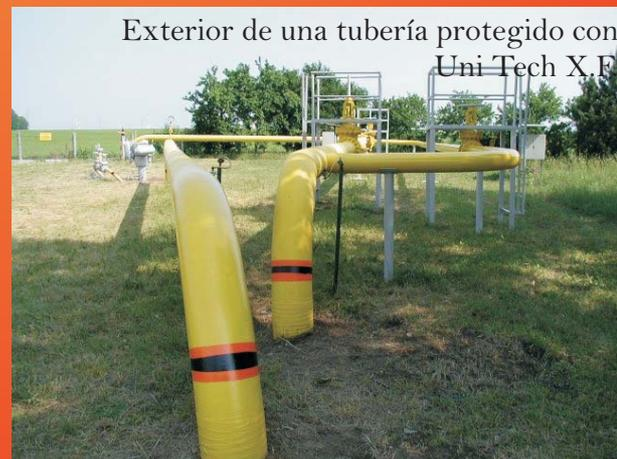
Exterior de una tubería protegido con Uni Tech X.F.
