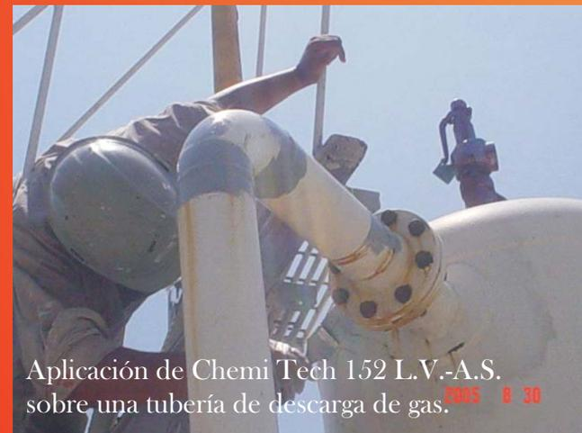
Aplicación de Chemi Tech 152 L.V.-A.S. sobre una tubería de descarga de gas.
