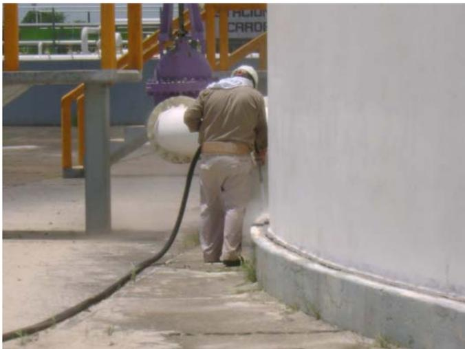
EN LA **BATERIA CARDENAS NORTE**, PROPIEDAD DE PETROLEOS MEXICANOS, SE REALIZO LA REPARACIÓN DE 4 FUGAS Y EL SELLADO ENTRE LA BASE DEL TANQUE TV2 Y SU CORRESPONDIENTE ANILLO PERIMETRAL.
