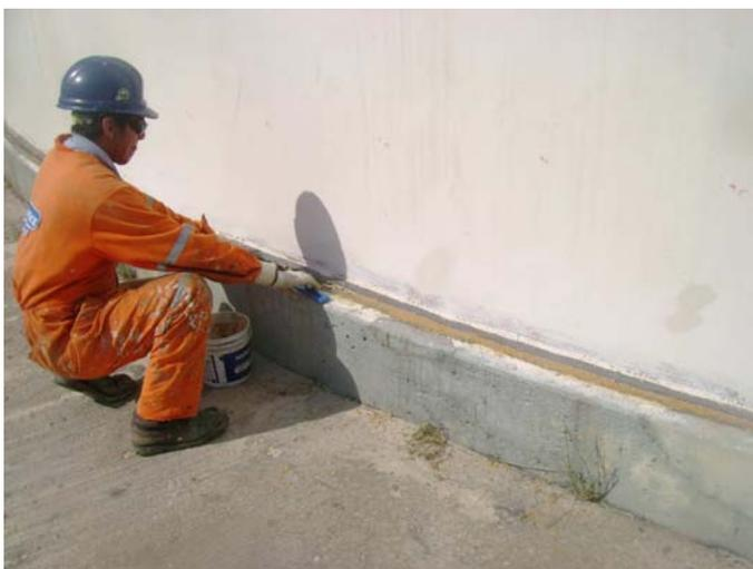
SE REALIZO EL SELLADO DE LA BASE, EN TODO EL CONTORNO DEL TANQUE, MEDIANTE LA PREPARACION DE UN MORTERO CON RESINA EPÓXICA **FLOOR TECH SP PRIMER**, MARCA THORTEX Y ARENA SILICA, MISMA QUE SE INTRODUJO EN LA PARTE INFERIOR DEL TANQUE HASTA UNA PROFUNDIDAD PROMEDIO DE 2 PLG.
