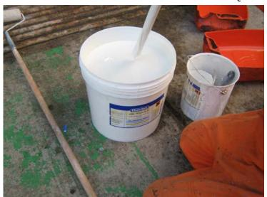
Una vez que el taller ha sido lavado y el piso se encuentre seco, se debe aplicar en todas las áreas interiores de talleres el recubrimiento THORTEX UNI TECH G.P. PRIMER, primario epóxico base agua de dos componentes.
