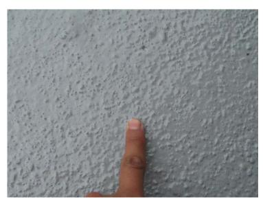
En áreas exteriores se deben aplicar dos capas del recubrimiento de poliuretano 100% sólidos y libre de solventes THORTEX FLOOR TECH F.B. a un espesor de 10 milésimas c/u (250 micrones) incorporando agregado antiderrapante entre ambas capas. Este es un recubrimiento diseñado para aplicarse en áreas expuestas a tráfico peatonal severo y que se encuentren operando en exteriores. El sistema posee excelente resistencia a rayos UV, cuenta con excelente retención de color y brillo.
