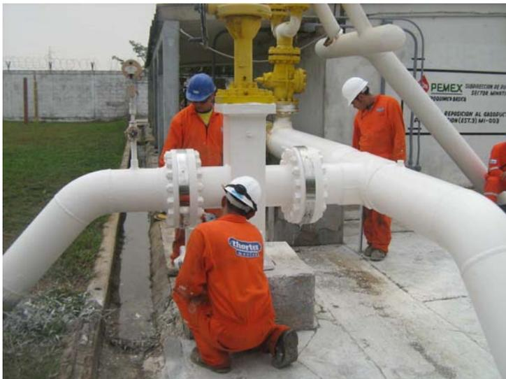
Una vez aplicado el recubrimiento en las bridas, espárragos y cualquier area de difícil acceso, se aplicó el recubrimiento THORTEX CHEMI TECH 152 L.V.-A.S. sobre toda la superficie del ducto con equipo airless.
