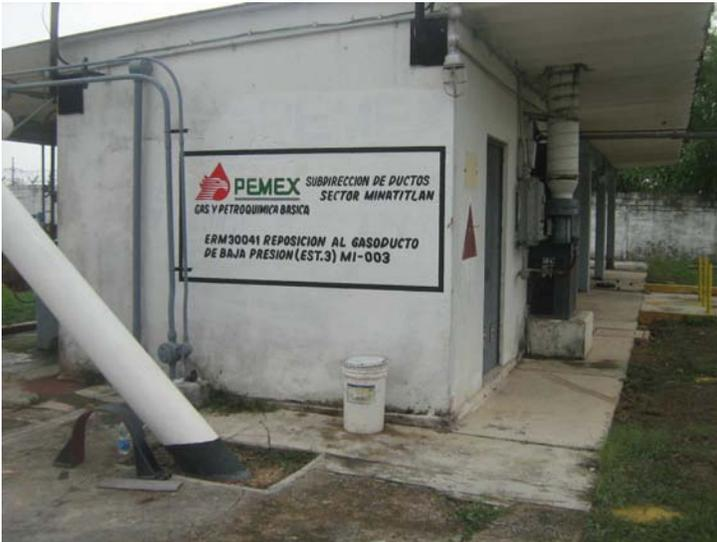
En las instalaciones superficiales de PEMEX GAS Y PETROQUIMICA BÁSICA es común el problema de condensación de humedad debido a la baja temperatura de la superficie de los ductos. Esto normalmente crea problemas de corrosión y es difícil llevar a cabo la aplicación de cualquier tipo de protección a dichas instalaciones.
